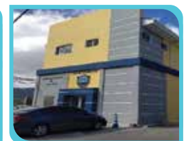
Data Center Telemática, Complejo SEDS. Costo: L. 36,193,650.00
