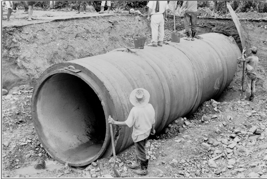
Alcantarilla de tubo de concreto reforzado Clase IV D = 72". Reconstrucción Carretera Tela-Ceiba.
