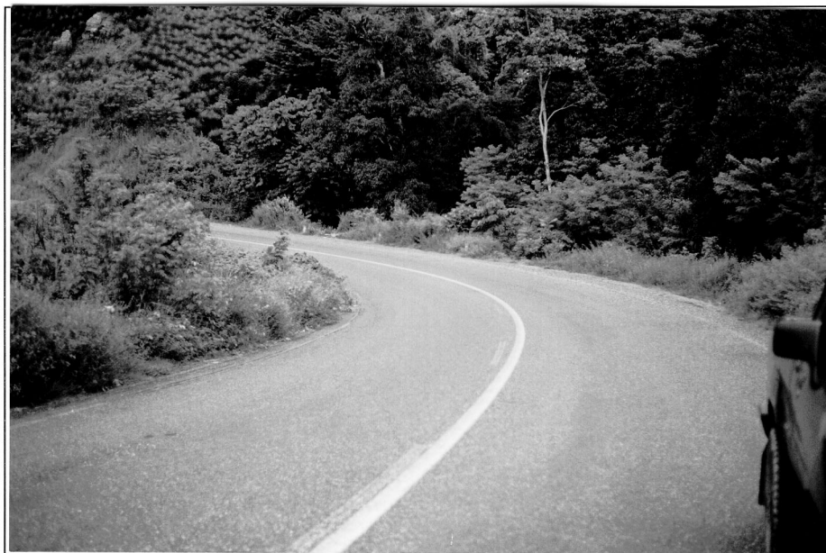
Obstrucción lateral por maleza en el lado cóncavo de la curva horizontal.
