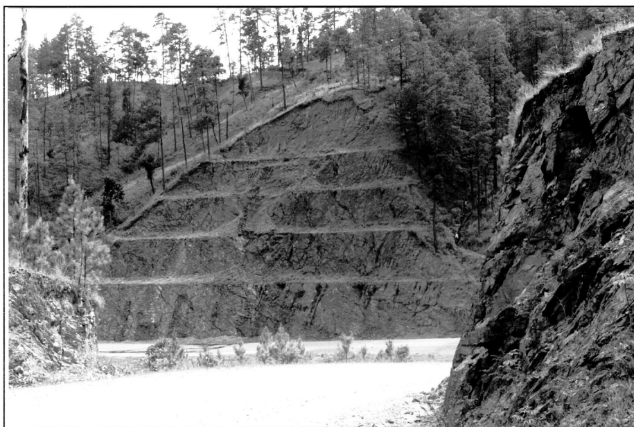
Tratamiento de taludes con bermas. Tramo: La Unión-Mame.
