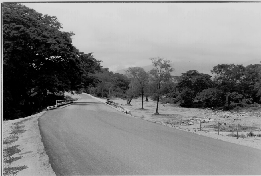
Puente Manchaguala en la carretera San Pedro Sula-Santa Bárbara.
