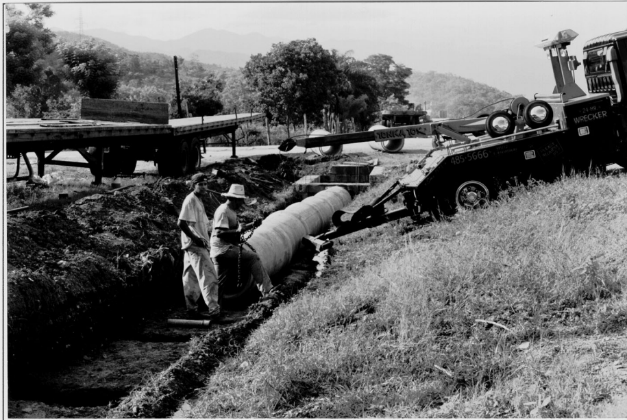
Conducto en tubería de concreto reforzado. Boulevard Villanueva. San Pedro Sula.
