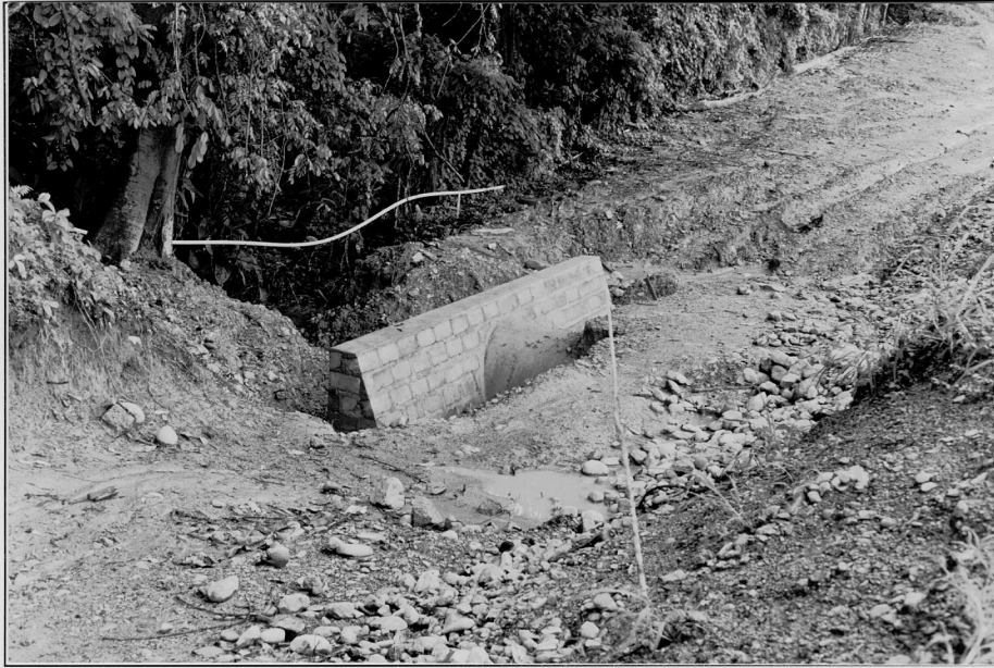
Cabezal recto de bloques sólidos de concreto. Reconstrucción Carretera Tela-Ceiba.
