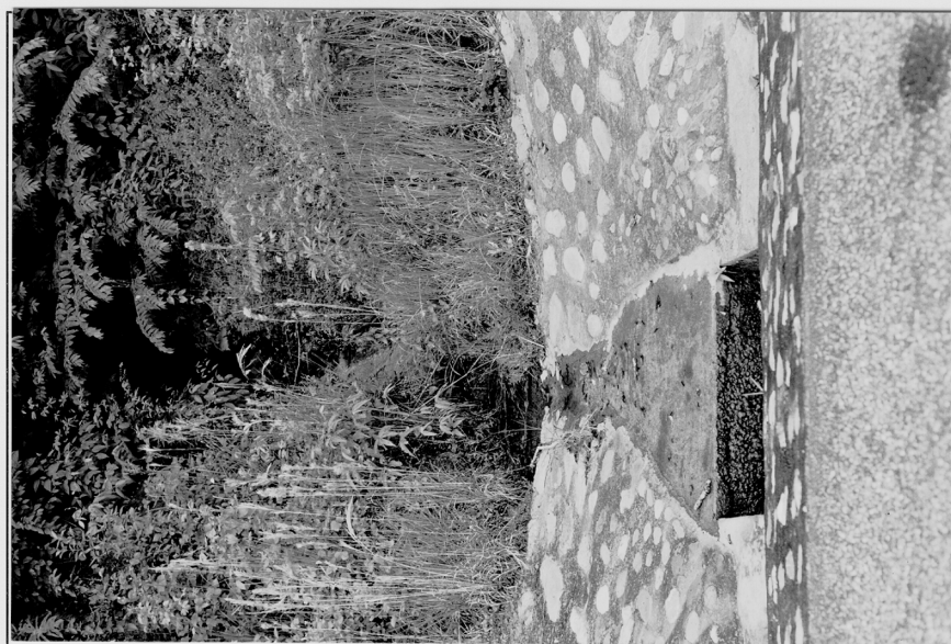
Cabezal tipo "L" con descarga lateral. Autopista Villanueva. San Pedro Sula.
