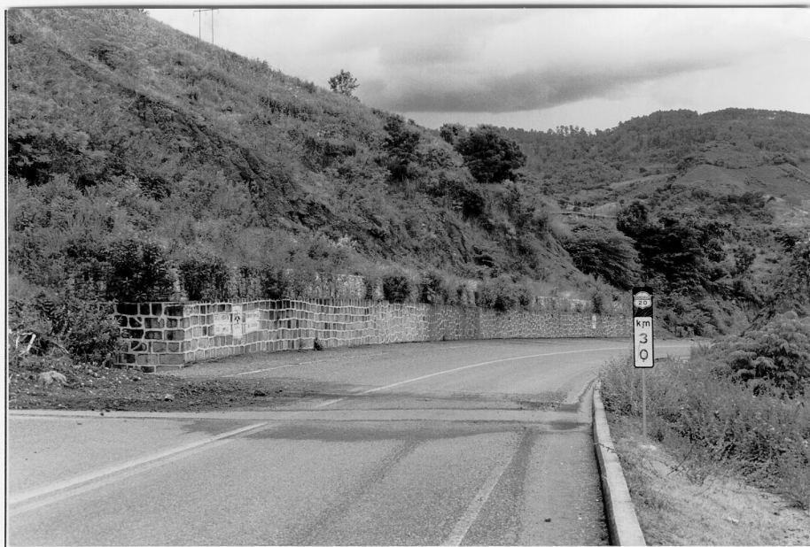
Combinación de muro de mampostería y gaviones. Tramo: Pito Solo-Santa Bárbara.
