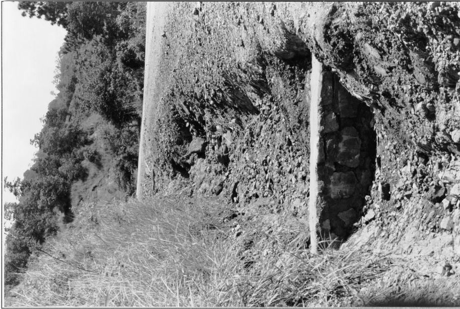
Obra Sabó sobre río Gila (Santa Rosa de Copán). En algunos casos es necesario hacer obras fuera de la zona de camino (como esta estabilización del cauce mediante saltos) para proteger la infraestructura vial.
