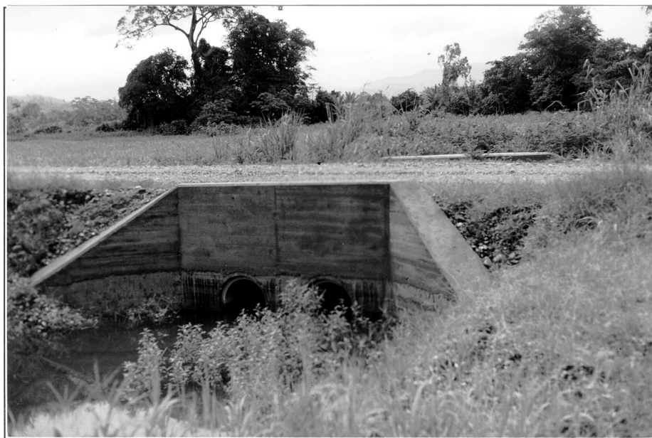
Alcantarilla con aletones. Camino vecinal. Tramo: Astillero-San José de Texiguat.
