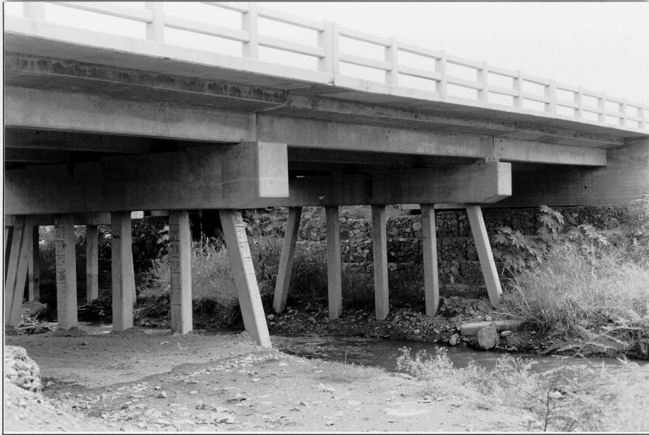
Puente sobre caballete de pilotes. Tramo: La Lima-Progreso.
