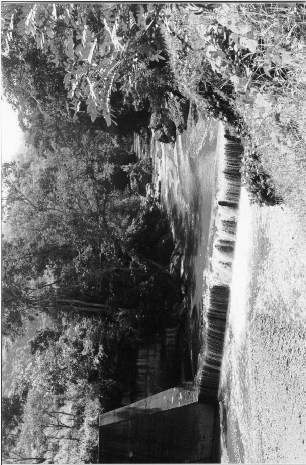
Obra Sabó sobre río Gila (Santa Rosa de Copán). En algunos casos es necesario hacer obras fuera de la zona de camino (como esta estabilización del cauce mediante saltos) para proteger la infraestructura vial.
