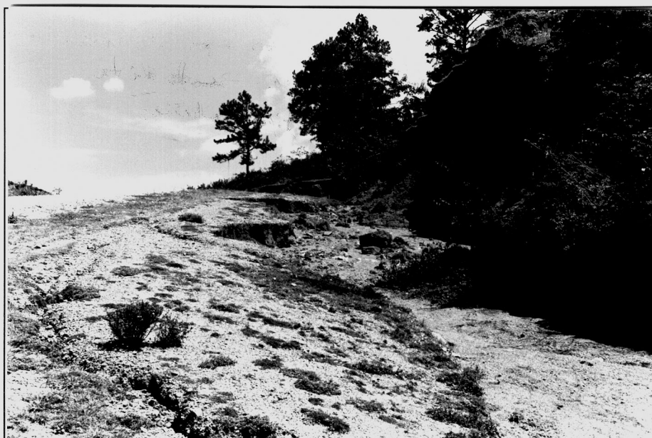
Erosión en cunetas y talud.
