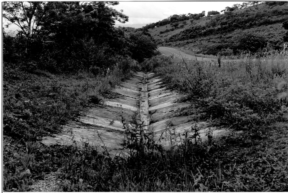
Revestimiento de cuneta. Tramo: Pito Solo-Santa Bárbara.
