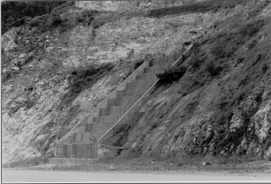
Rápida escalonada. Tramo:La Unión-Mame. Notese barrera de gaviones en la parte superior derecha.
