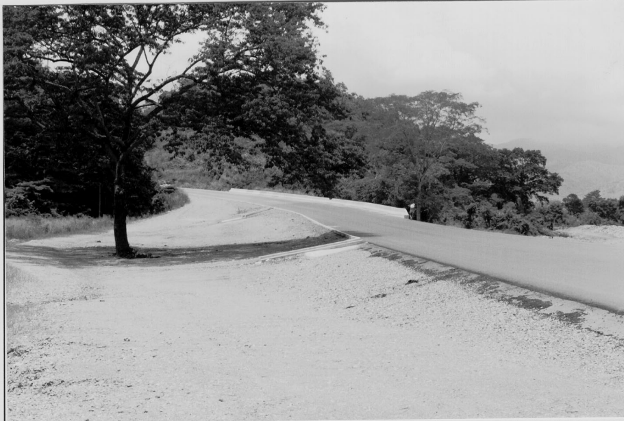
Rápidas de descarga de bordillos. Tramo:San Pedro Sula-Cofradía.
