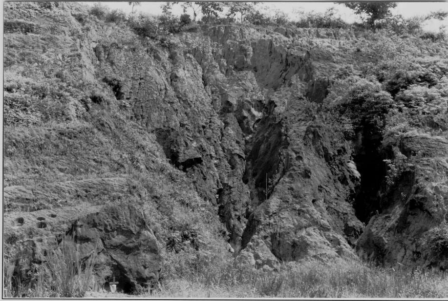
Derrumbe de talud provocado por aguas subterráneas.
