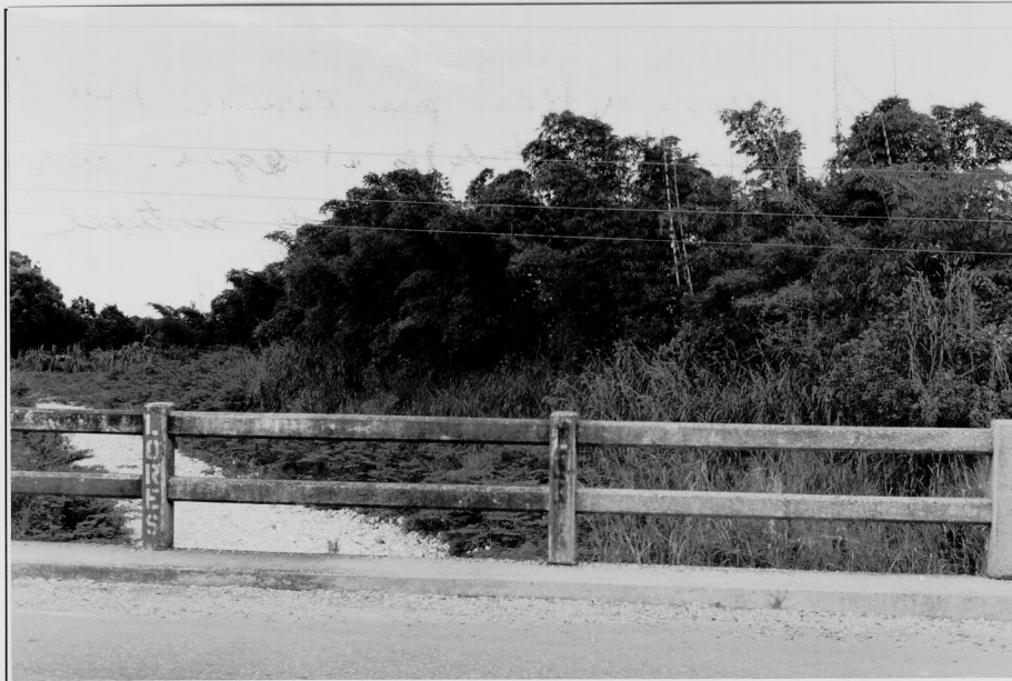
Puente sobre quebrada seca. Tramo: Tela-Ceiba.
