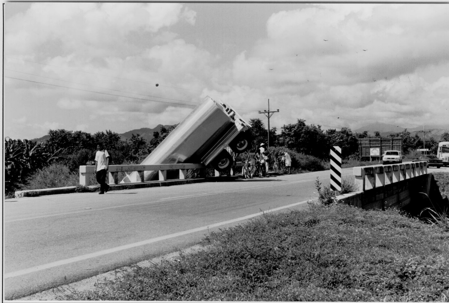
Puente aliviadero sobre río Aguas en Savá.
