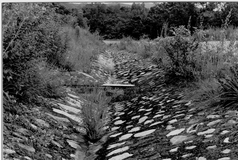
Revestimiento de cuneta y diques retardadores (check dams). Tramo: Pito Solo-Santa Bárbara.
