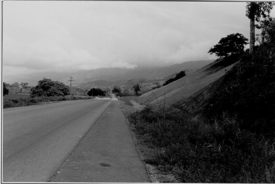
Estabilización del talud.
