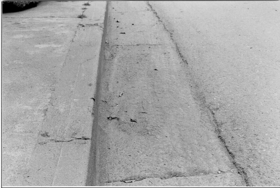
Bordillo de concreto junto a carpeta de rodadura asfáltica. Progreso-Yoro.
