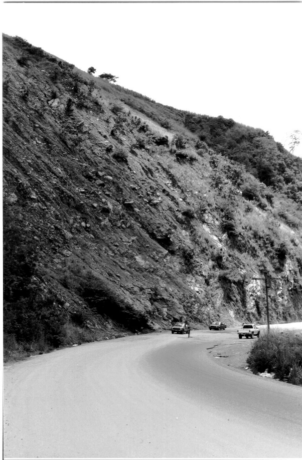
Talud de gran altura. Tramo: San Pedro Sula-Santa Bárbara.
