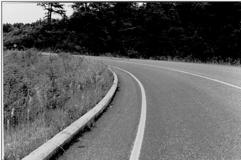
Bordillo de conducción longitudinal en zona peraltada. Tramo: Pito Solo-Santa Bárbara.
