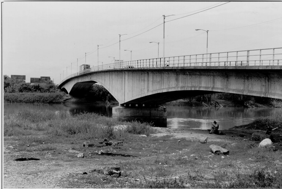
Puente Omonita. Río Ulúa.
