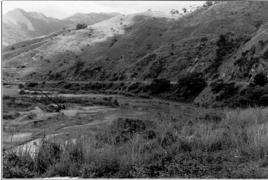
Trazado aledaño al río Chamelecón. Tramo: San Pedro Sula-Naco. Se observa la extracción masiva de material del lecho aspecto grave que debe ser regulado por las autoridades.
