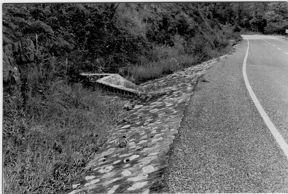
Descarga lateral de cuneta. Tramo: Pito Solo-Santa Bárbara.
