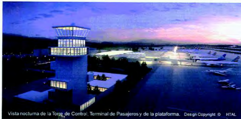
Vista nocturna de la Torre de Control, Terminal de Pasajeros y de la plataforma. Design Copyright © HTAL
