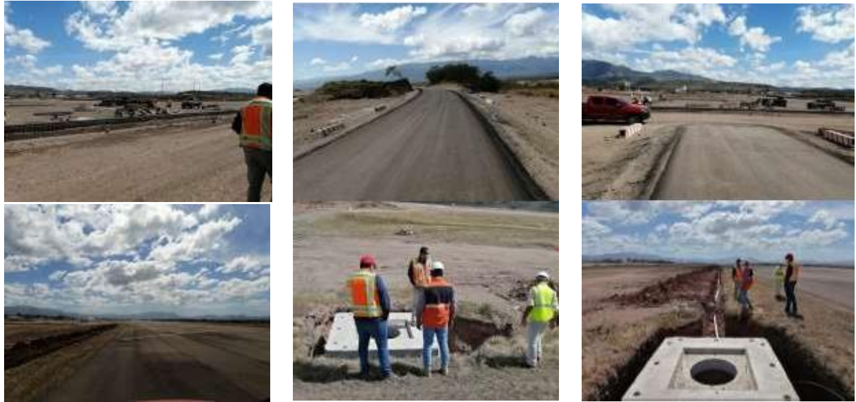
OBRAS DEL CONCEDENTE: Construcción y pavimentación de la franja de pista, obras de canalización para balizamiento
