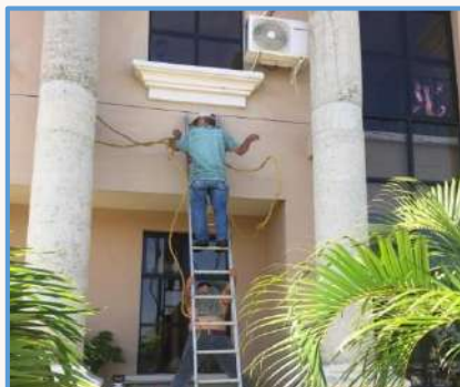
Trabajos de Mantenimiento de Aires acondicionados.
