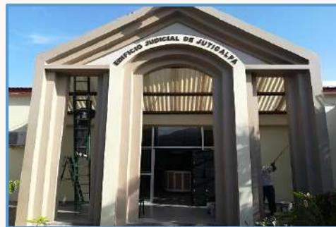
Trabajos de Pintado del Edificio Judicial de Juticalpa, departamento de Olancho.
