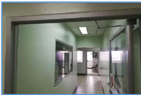
Trabajos de Pintado del Juzgado de Letras de Violencia Doméstica.
