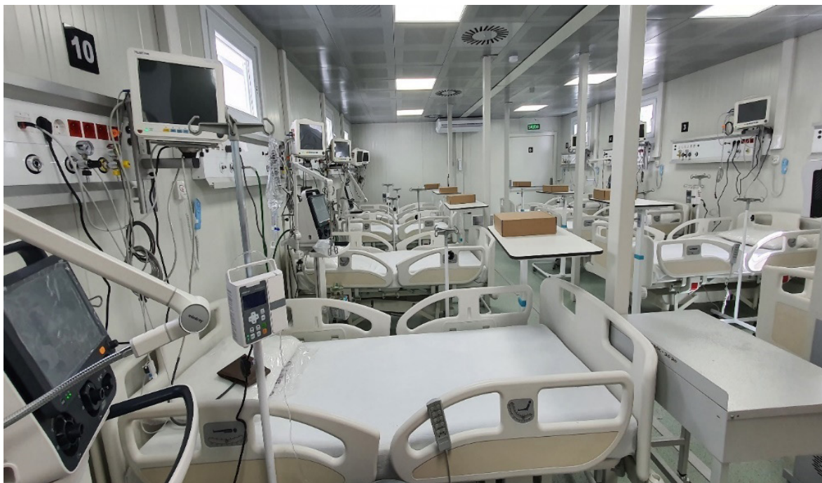
Área de UCI con insuficiente espacio para paciente requerido, sistema de climatización inadecuados, distanciamiento del 1.5 metros incumplido, insuficiente equipo de bombas de infusión peristáltica y bomba de infusión por jeringa.
