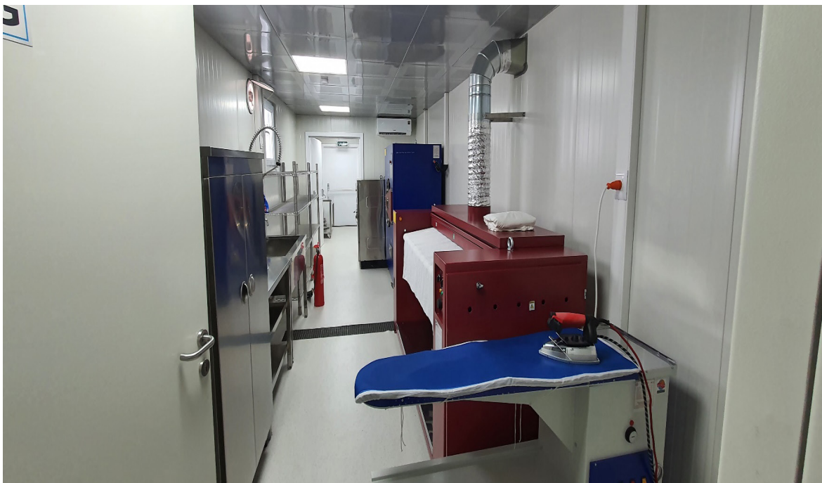
Esta área de lavandería no se utilizará por riesgo a exposición de contagio.
