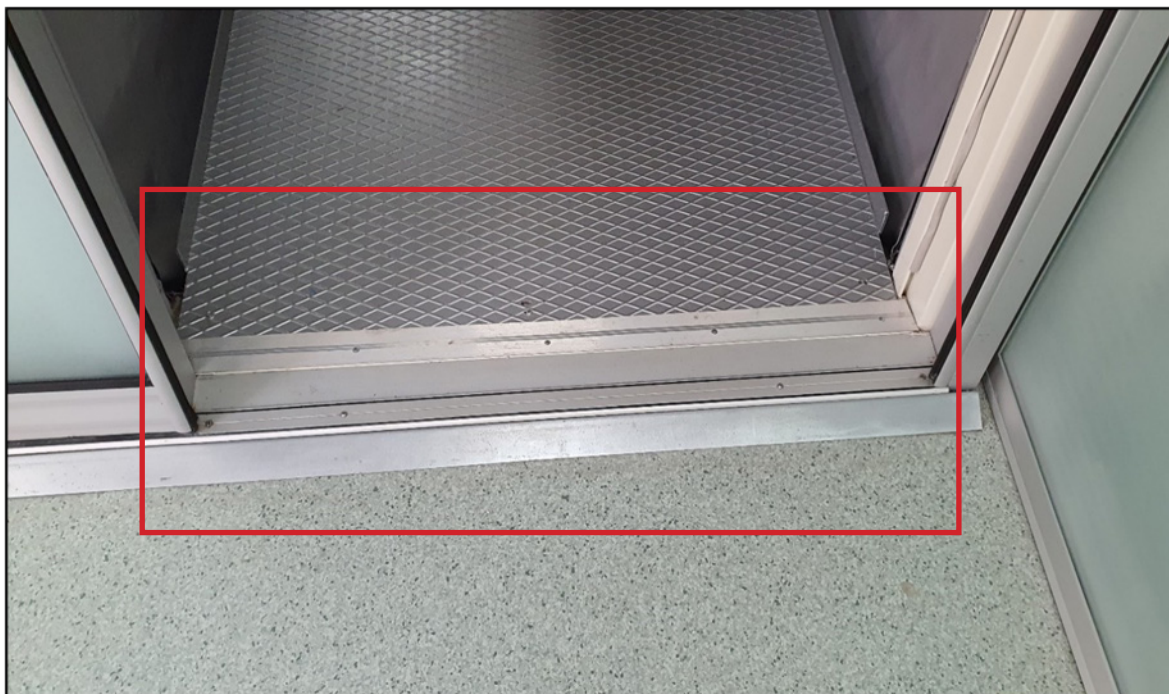
Este tipo de molduras biseladas para pisos no se recomienda por que impiden el flujo de camillas.
