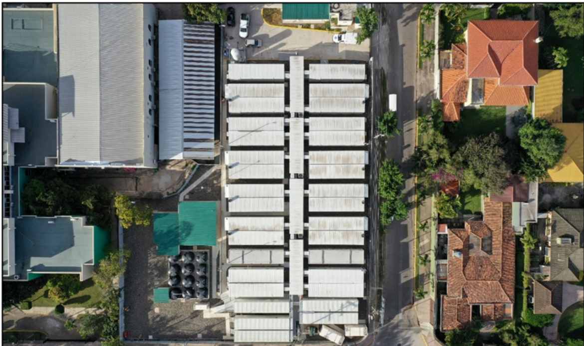
Sistema de climatización por mini-split no adecuado por la naturaleza del coronavirus.
