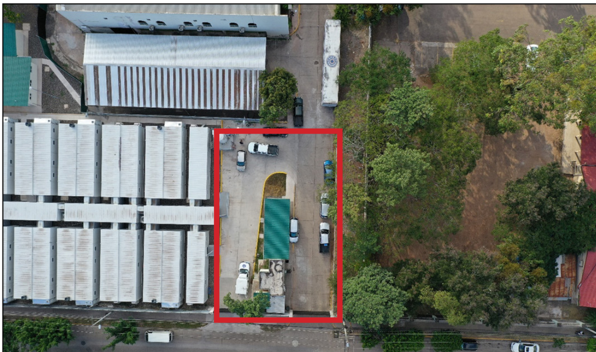
Insuficiente área de estacionamiento vehicular para personal y camión de basura.
