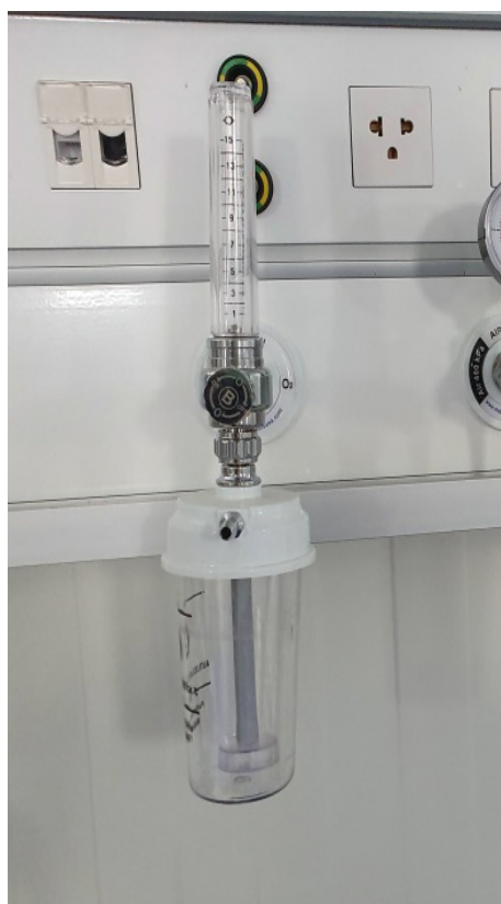
Flujómetro con humidificador de máx. de 15 LPM
