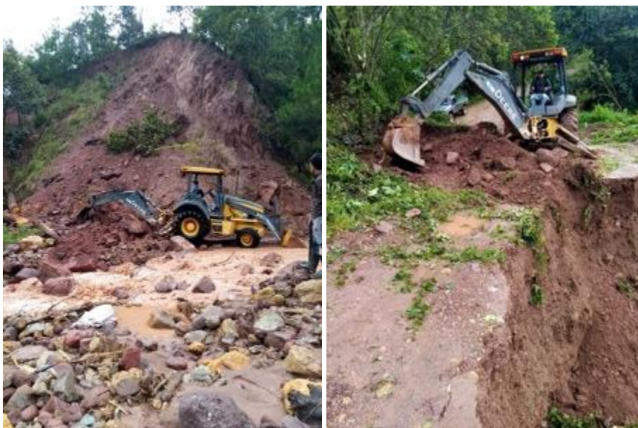
IMAGEN 7. DERRUMBE Y DESLIZAMIENTO SOBRE CARRETERA EN SAN AGUSTÍN, COPÁN
